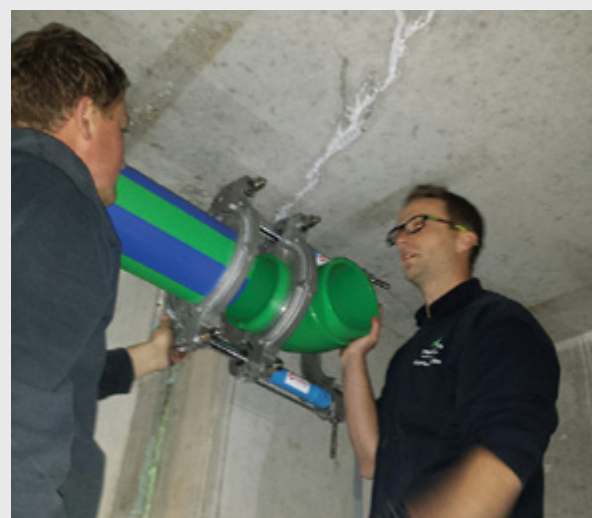
Bild 3: Platzsparende Verschweißung durch WIDOS-Kompakt-Zweiring
