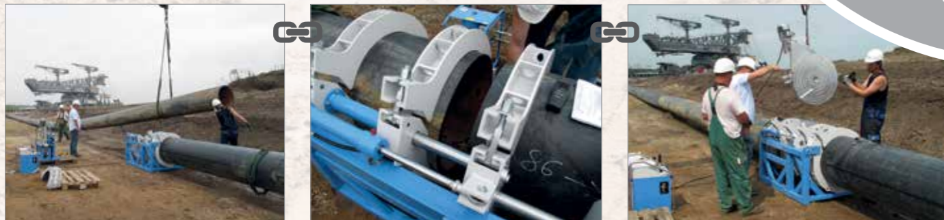
• Vorbereitung zum Verbinden zweier Rohrstränge DA 800 sowie Planhobeln und Versatzprüfung
