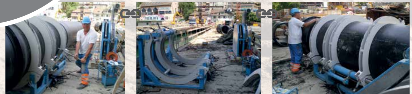
• Einspannen der beiden Rohrenden DA 1200 zum Planhobeln vor dem Verschweißen
